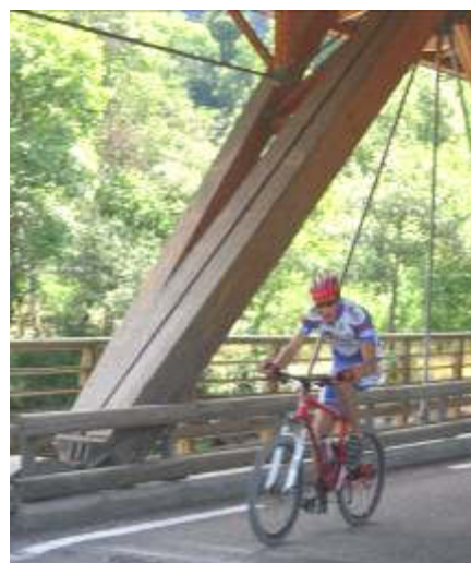
Jérôme sous le pont des Fayettees
