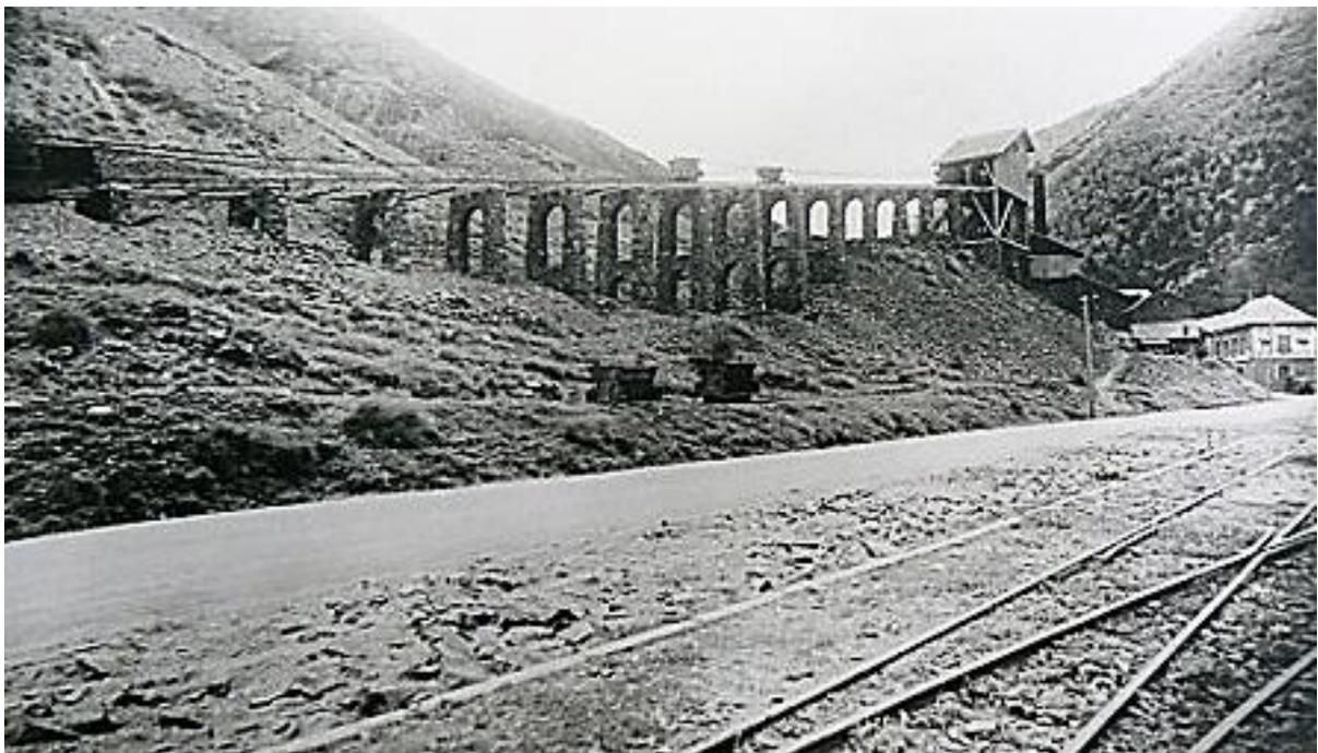
En 1921, le plan incliné, avec les wagonnets tractés par des câbles, remplace la corvée harassante des chevaux pour transporter les pierres calcaires jusqu'aux fours. Des chariots amenaient là les pierres extraites de la carrière sise en rive gauche de la Bonne, par un petit pont privé enjambant le torrent.
