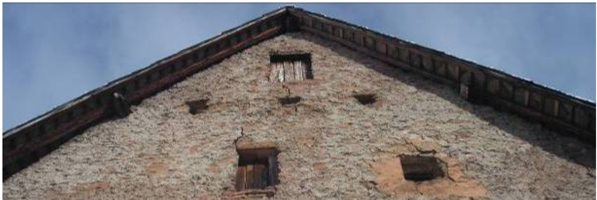
Vestiges de plâtre rouge des Sauvons sur l'ancienne cure des Nicolos, hameau de Valbonnais.
