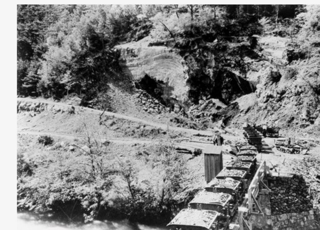
Transport de pierres dans des wagons
